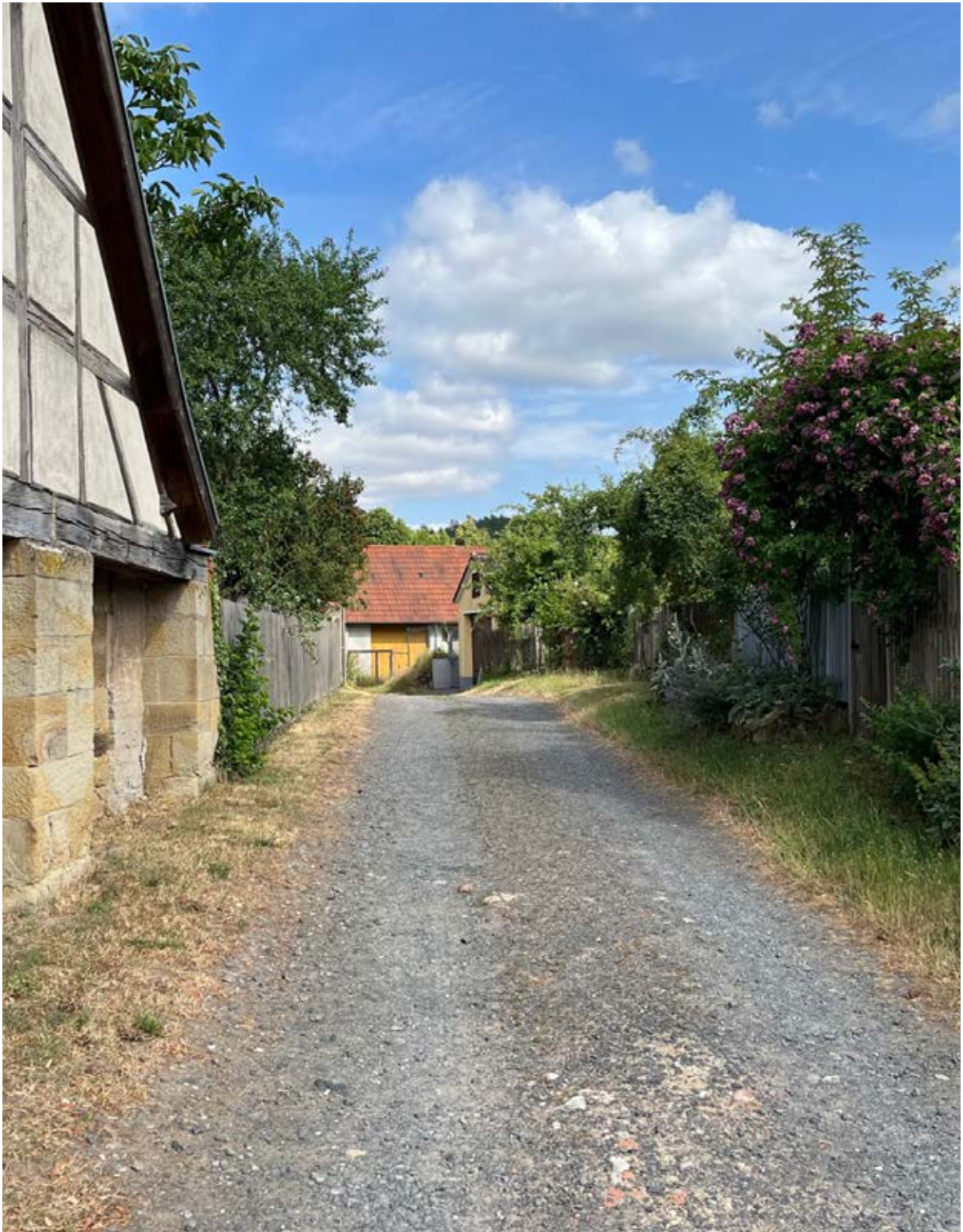
Wassergebundene Splittdecke im Mauerweg, p&w 2024
