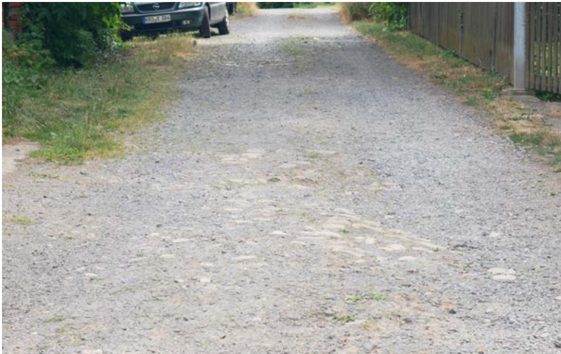
Deckschicht aus Splitt am Stadtgraben, p&w 2023
