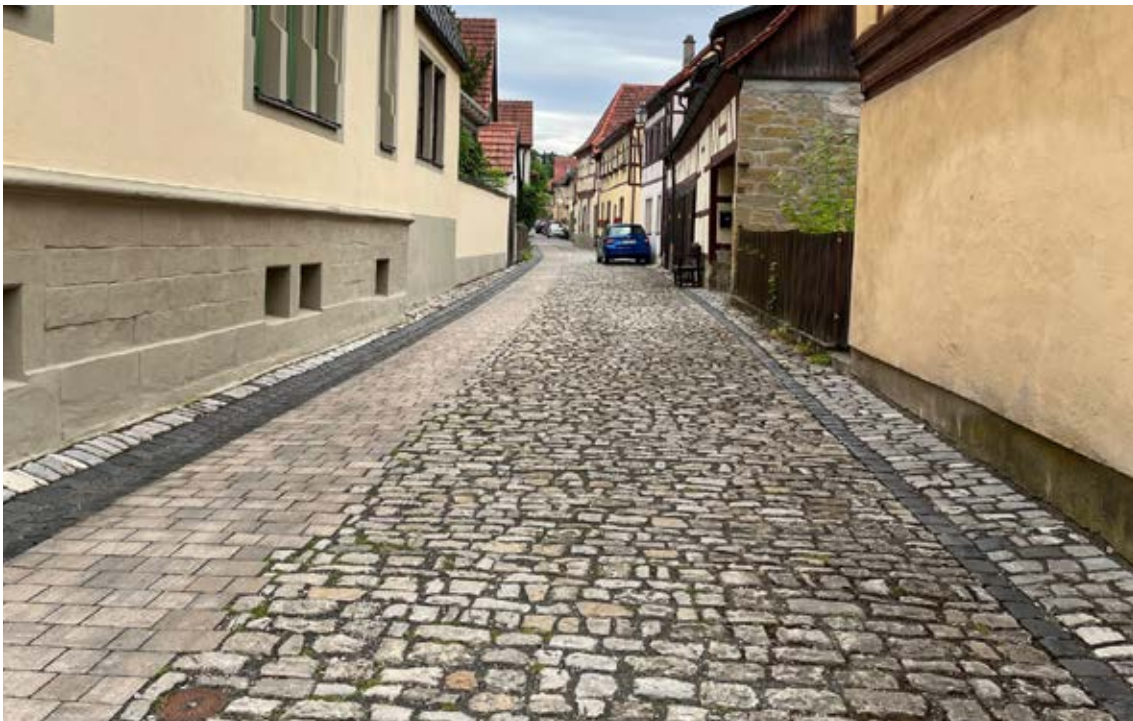
Der Gehfreundliche Streifen wurde 2012 als Versuchsfläche in der Tretgasse eingebaut, p&w 2023
