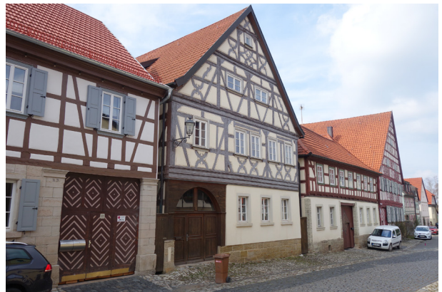
Die Bebauung ist geprägt durch eine geschlossene Reihung der Gebäude entlang der Straßen- und Platzräume.
